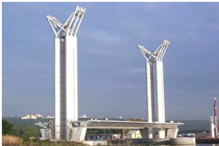
Figuur 1: De hefbrug Gustave Flaubert in Rouen gebouwd door Victor Buyck Steel Construction
